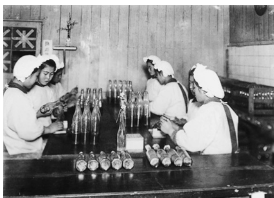
図4. シロップ瓶中の培地へのアオカビの植菌 【『森永製菓 100年史 (2000年)』より：森永製菓株式 会社提供】
